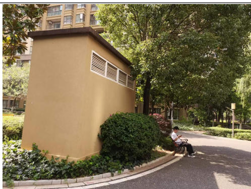
地下车库排气口
